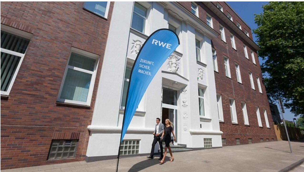
Zentrale des Energiekonzerns RWE in Essen.
